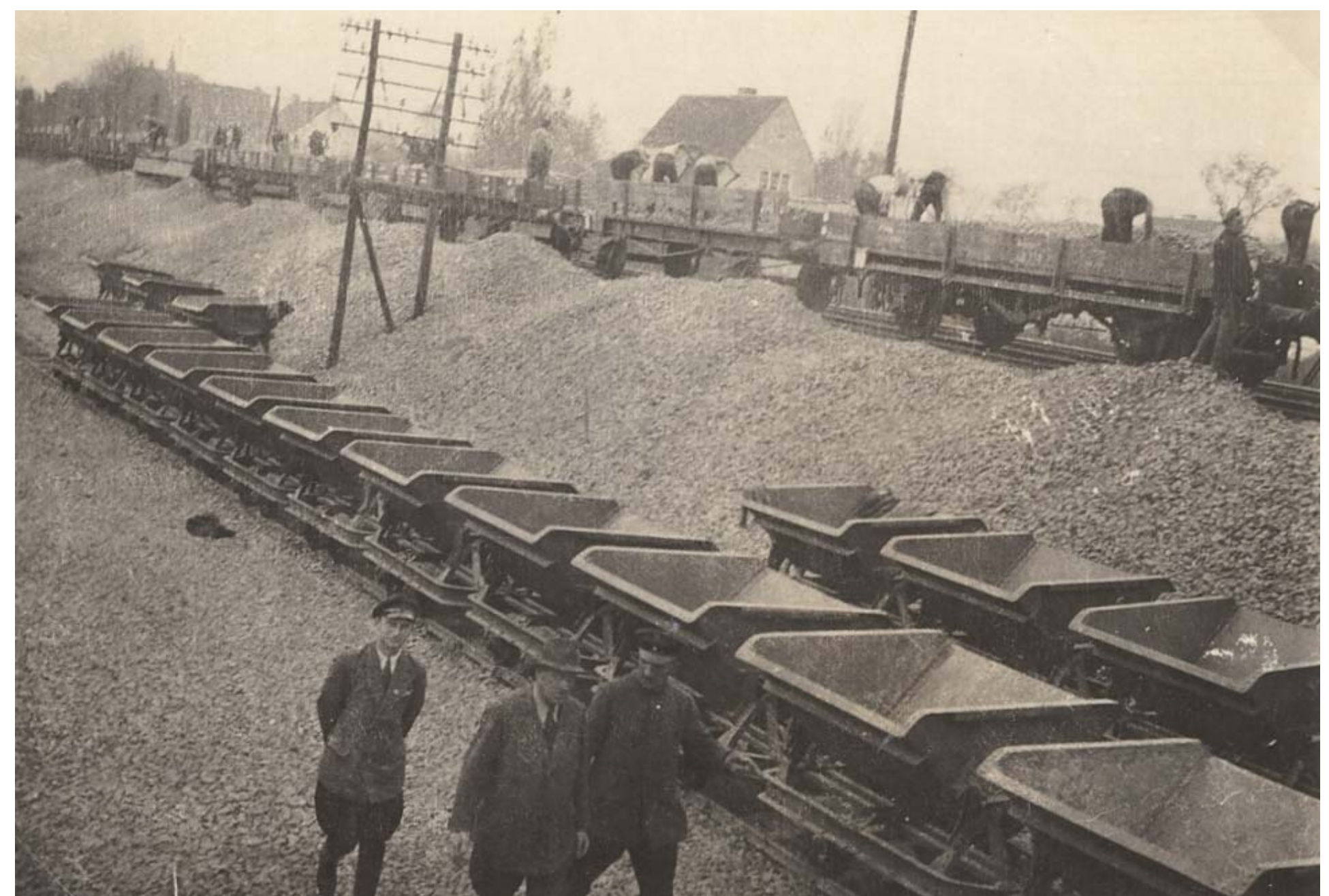
Bau des Eisenbahndamms von den Gärten der Berckstraße in Richtung Luisental, 1935
