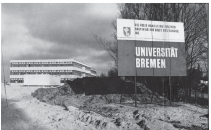
Bau der Universität um 1971
