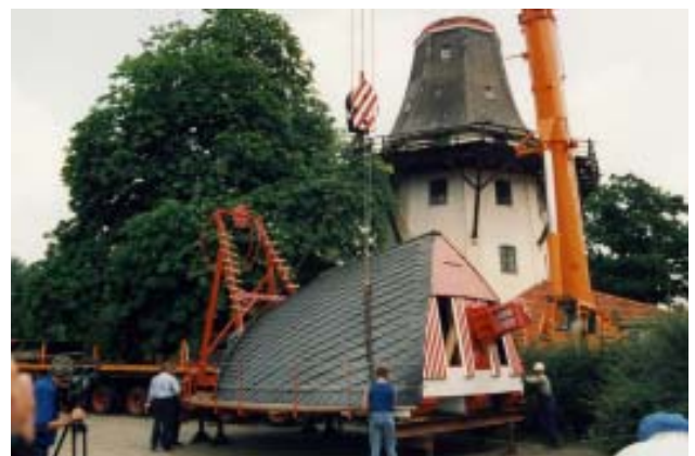
Antriebswelle und Mühlenkopf vor der Montage
