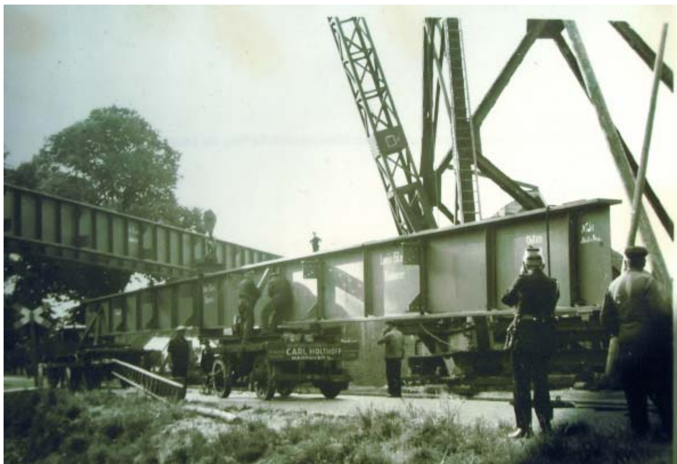
Schwerstarbeit: Einbringen der Träger für die Autobahnbrücke über die Leher Heerstraße
