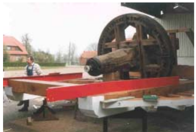
Antriebswelle und Mühlenkopf vor der Montage
