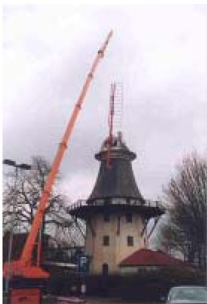
Ein Flügel wird eingehängt
