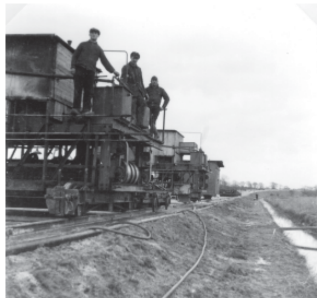
Langsam voran: Schienengebundene Baufahrzeuge gießen die Betonplatten
